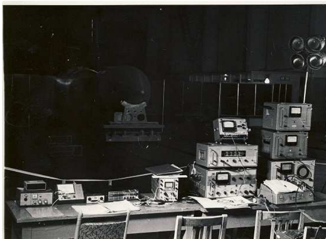
Sestava kontrolní aparatury při zkouškách na kosmodromu (zkouška již všech součástí dohromady).
